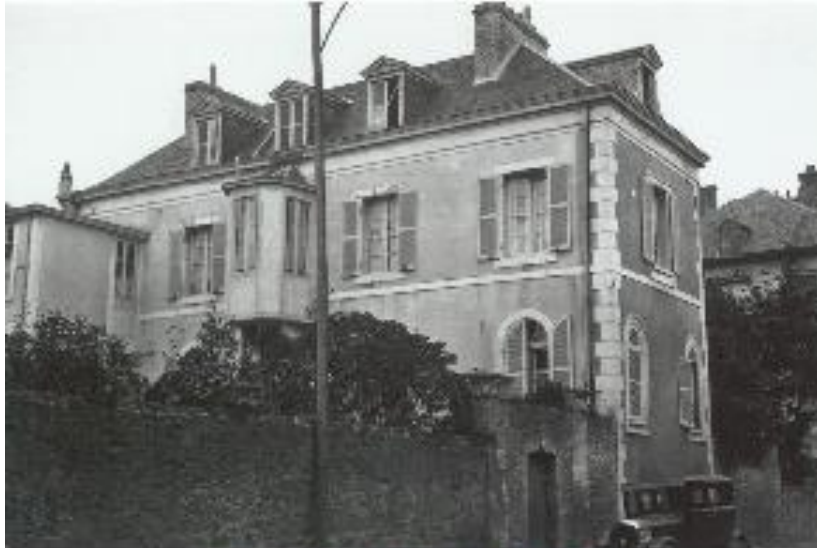
1929 - l'arrière de la Villa Florida
