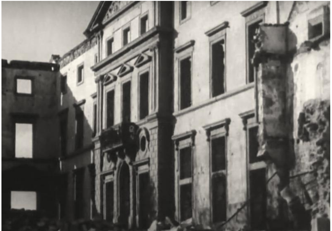
1944 : de l'hôtel de Ville, il ne reste que des façades instables ...
