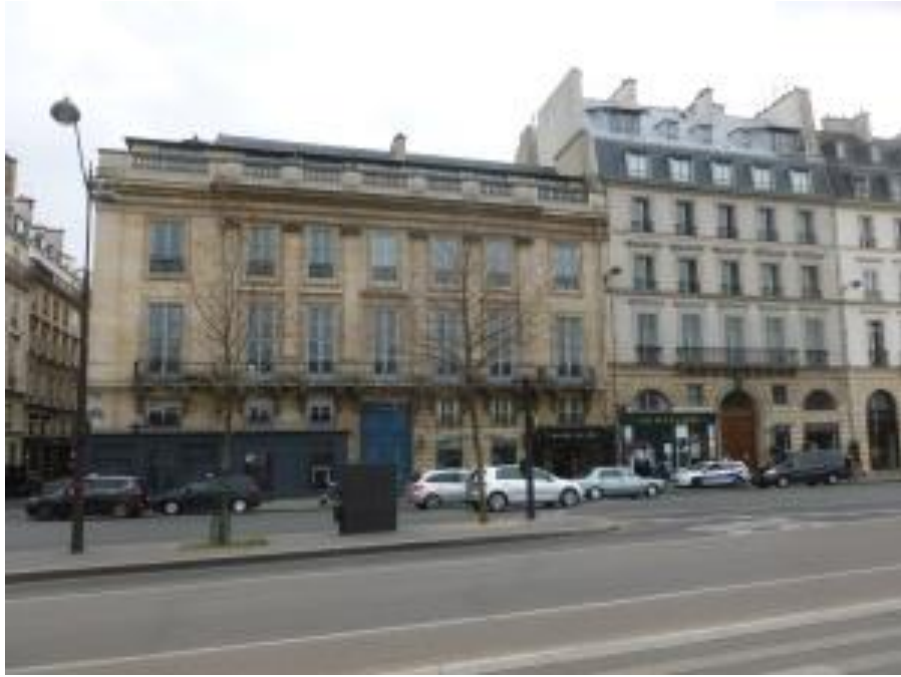
Au n°1 du quai Voltaire, à l'angle de la rue des Saints-Pères, l'hôtel de Tessé de 1765, avec en face, au-delà de la Seine, la grande Galerie du Louvre.
